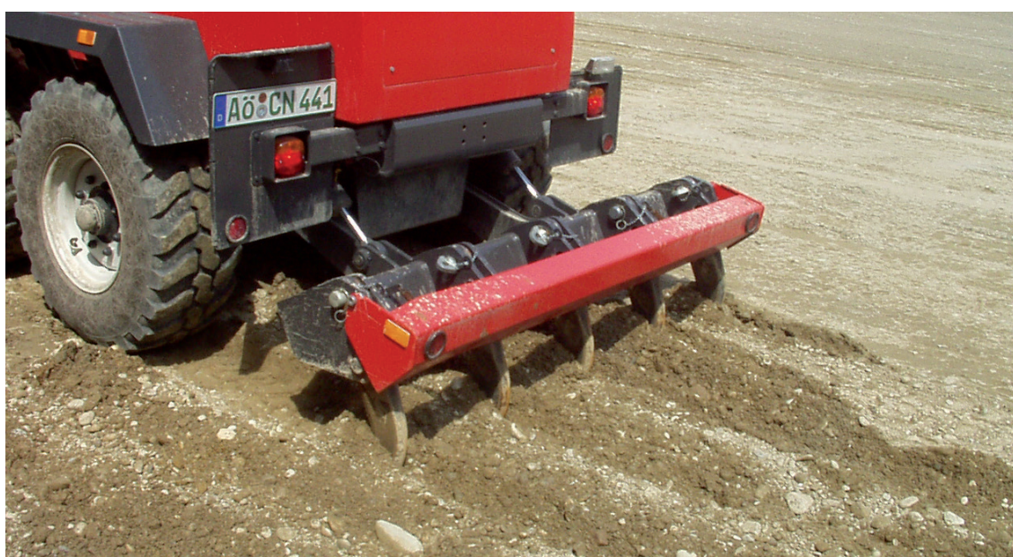
Abb.30: Baugrundlockerung nach Herstellen des Erdplanums
