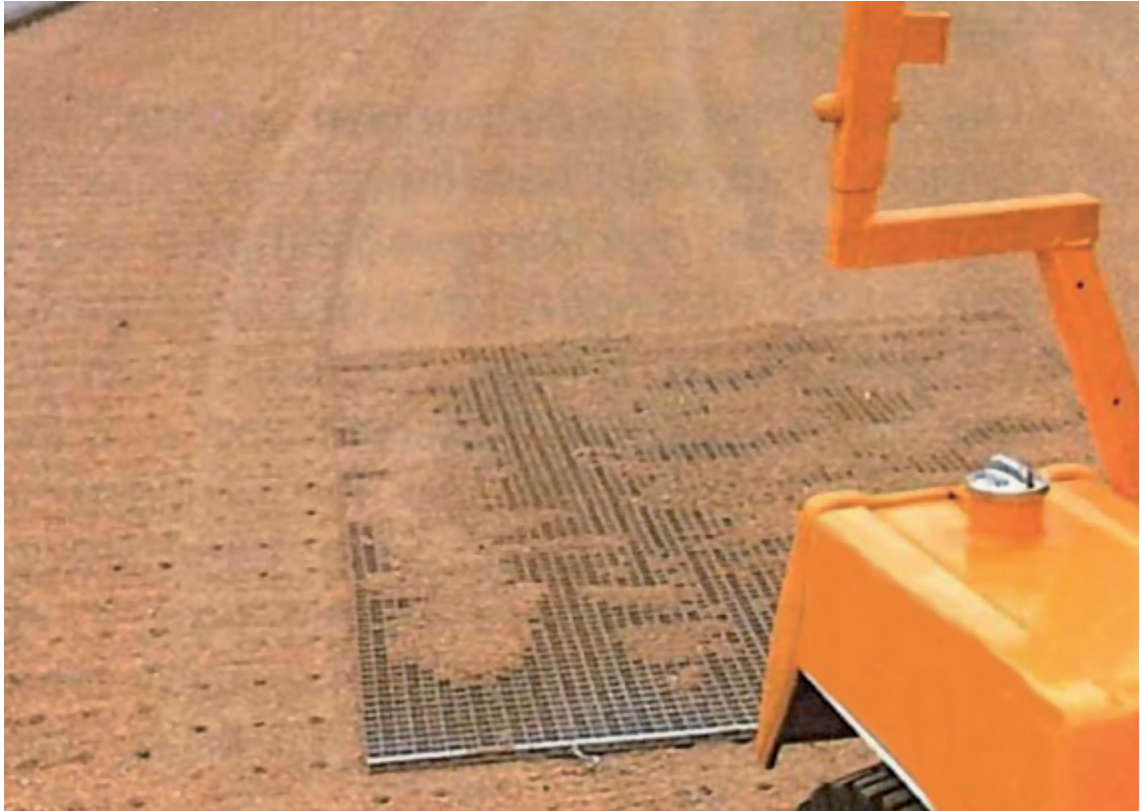
Abb. 89: Einschleppen des Stützkorns in die Lochkanäle
