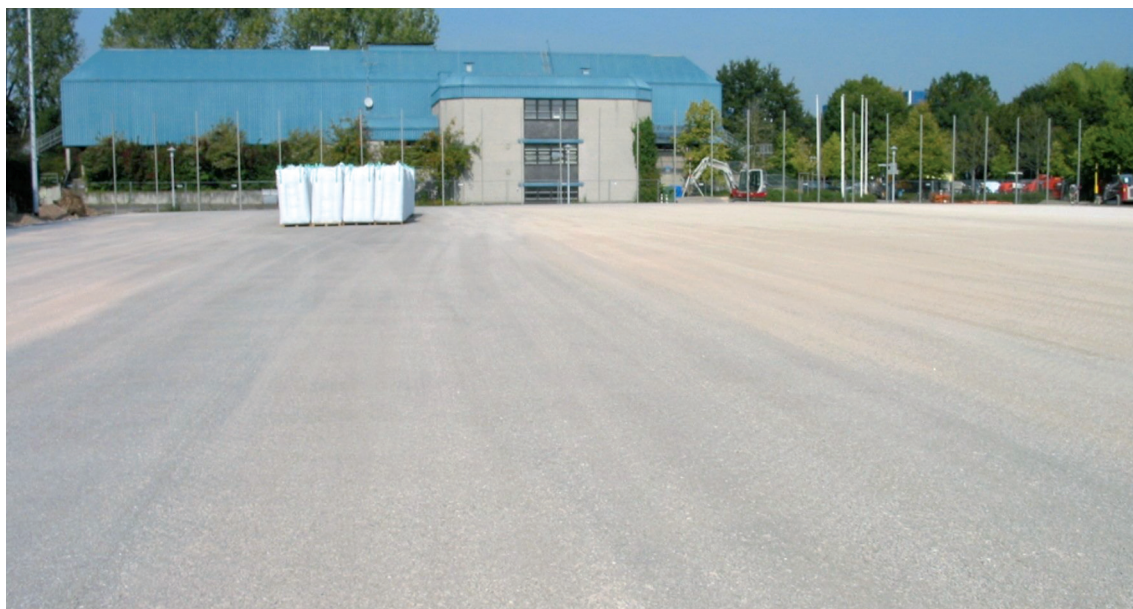
Abb. 129: Tragschicht ohne Bindemittel vor Einbau der gebundenen elastischen Tragschicht
