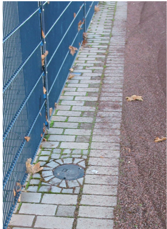
Abb. 24 und 25: Anordnung der Teilkreisregner im hindernisfreien Raum bei Kunststoffrasen- und Tennenflächen
